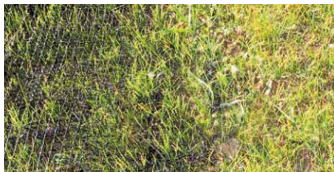
VIRMAT dopo ca. un mese, intasato di terra a destra, non intasato a sinistra
